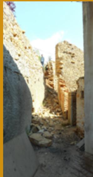
Le mur de soutènement en pierres sèches de ce chemin rural s'est effondré sur une longueur de 12 mètres linéaires, et a dû faire l'objet d'une reconstruction par l'entreprise de maçonnerie Pascal SANGOJARD de Germolles pour un montant de travaux de 16 073 € HT.
